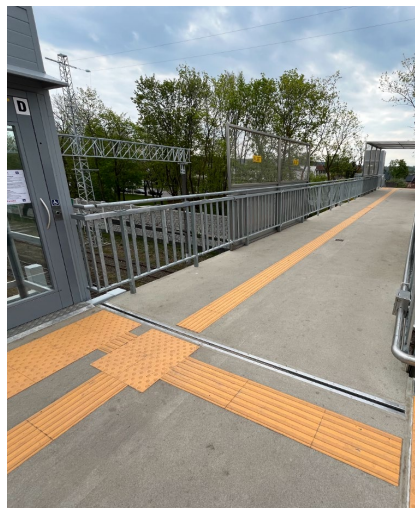
Klijuojami išpėjamieji paviršiai ant įrengtos dangos
